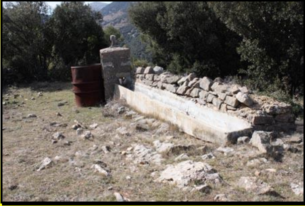
Cisterna del Tancat (L'Avellà)
