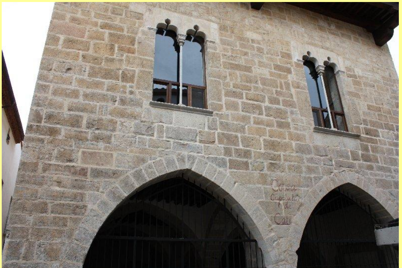
Fachada de la Casa de la Vila (Casa Capitular de Catí) después de la Luz de las Imágenes
