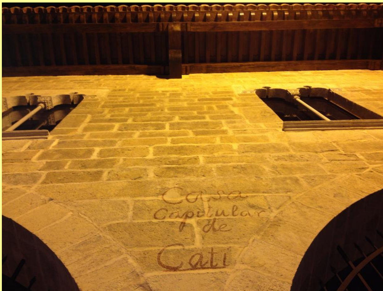
Casa Capitular, restaurada y iluminada
