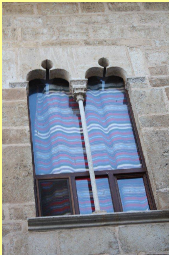
Ventanas gótica ajimezadas
