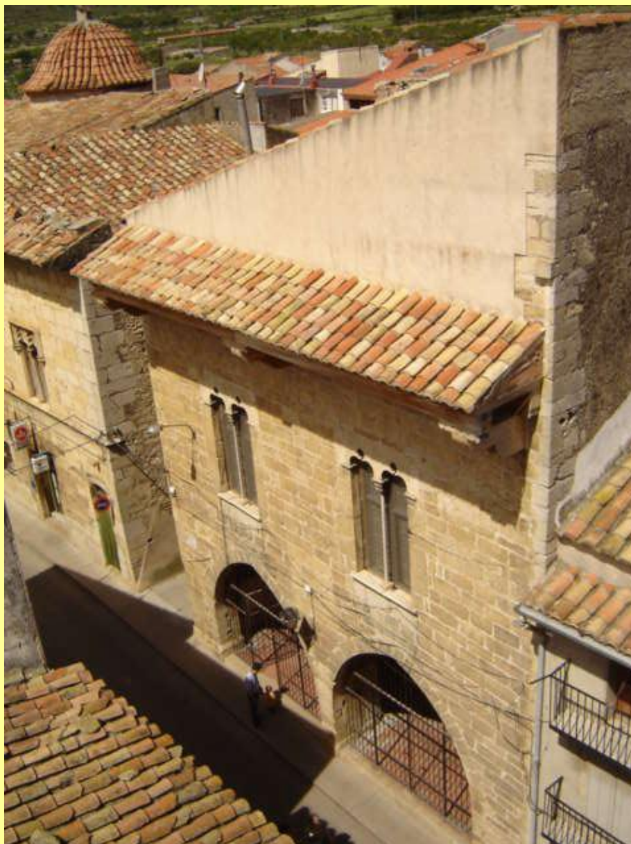
Vista des del campanar (27-05-06) sense la creu gran de fusta que hi havia damunt del ràfel que ja es veu restaurat
