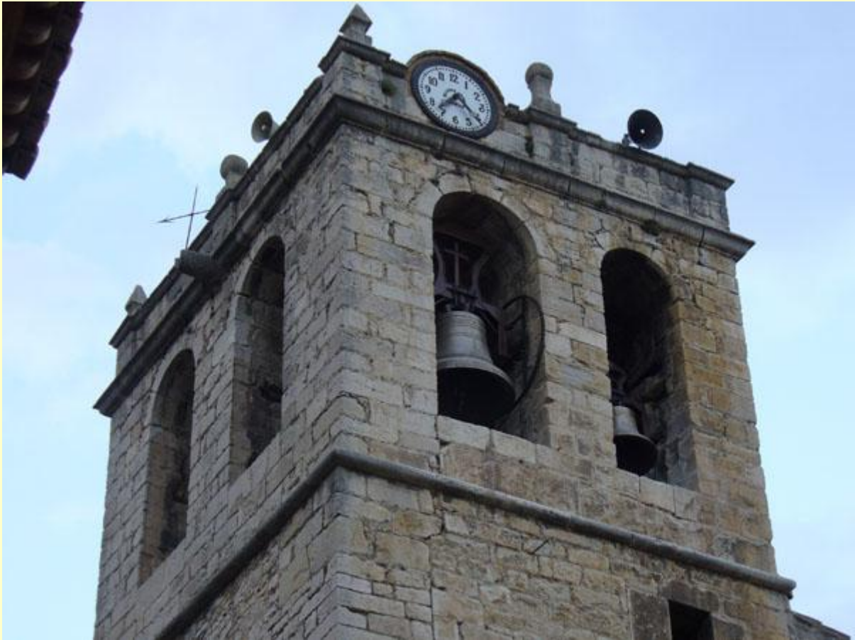
Fachada al sur y al oeste (con arcos recientemente destapados)
