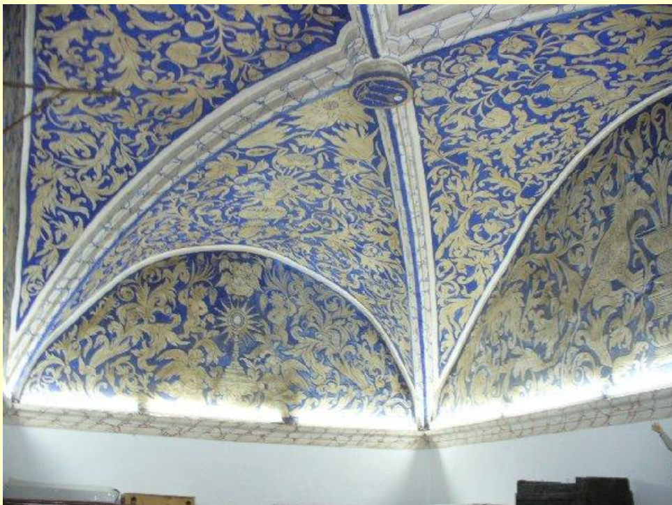
Bóveda de la sacristía
