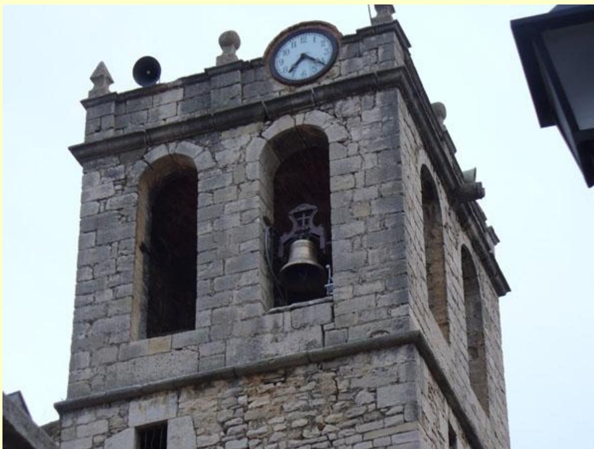
Fachada norte del campanario (arco recientemente abierto)
