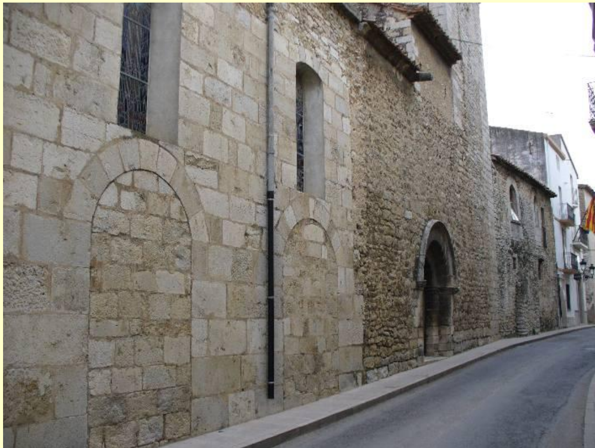
El año 1937 fueron cortadas las cuatro capillas laterales de la parte del evangelio, que daban al carrer Major y que estrechaban la carretera quedando la capacidad de la iglesia bastante reducida.
