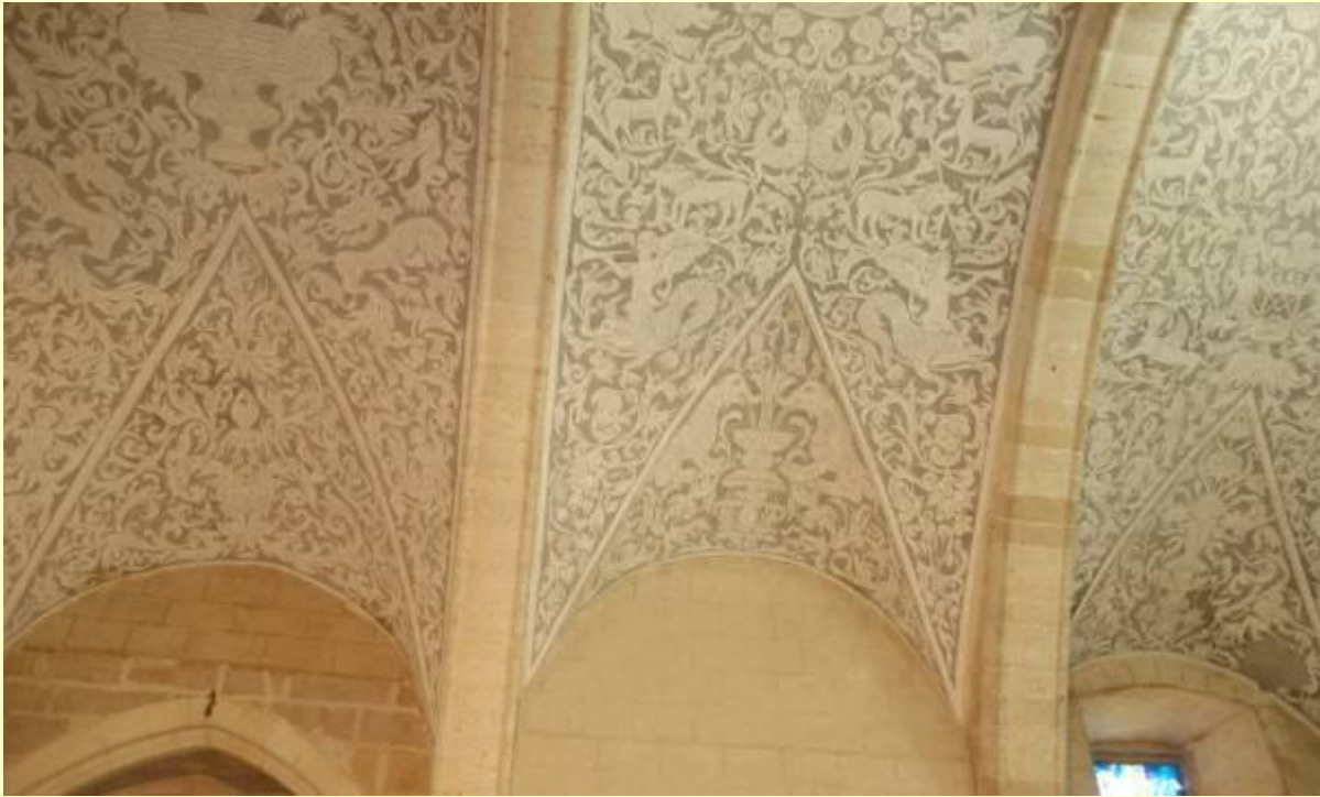
Esgrafiats de l'església de Catí, restaurats en el programa de la Llum de les Imatges (2014)
