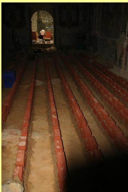
*Alzamiento del pavimento sobre el terreno unos 30 cm para crear una capa aislante.*
