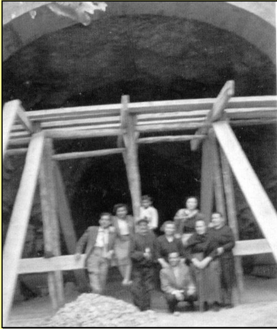
Embocadura del túnel ja acabada (17 de maig de 1953). Fot Alfredo Roca
