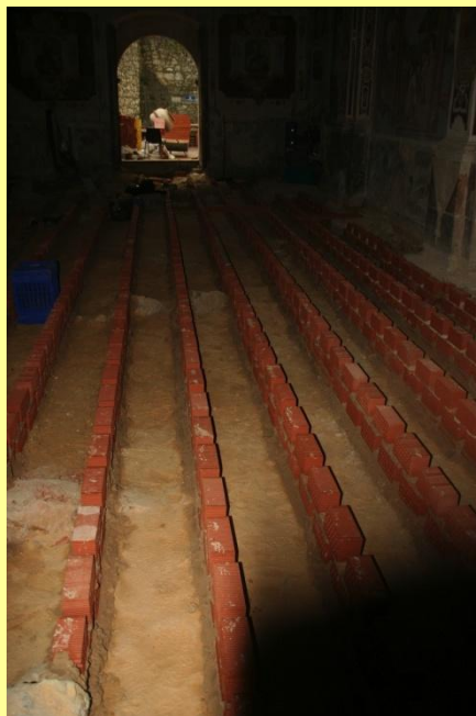
Alçament del paviment sobre el terreny uns 30 cm per crear una capa aïllant.
