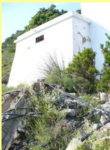
Primer dipòsit d'aigua, dalt de la caseta de la llum i que actualment fa les funcions de manteniment d'aigua corrent del balneari.
