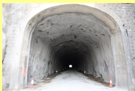
Obres d'encofrat del túnel (2012)
