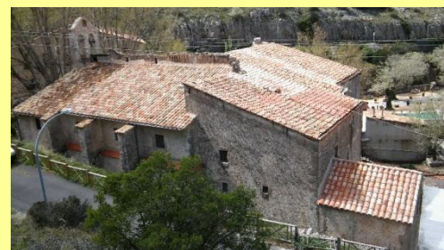
Vista de la teulada i l'espaldanya des del Nord-oest.
